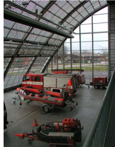
Solcellerna är väl integrerade i Houten brandstation, Nederländerna. Samyn and Partners, Belgien ( www.samynandpartners.be ). Foto: Dan Engström.
