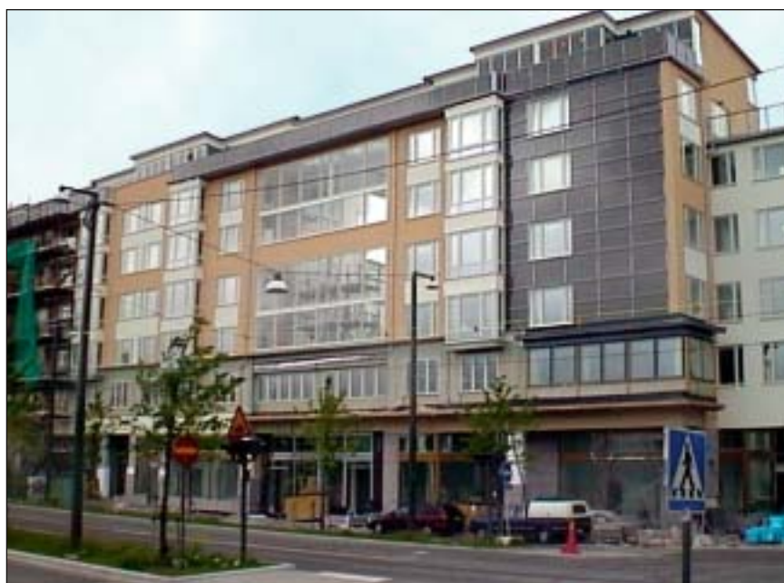
Byggnadsintegrerade solceller på NCCs kvarteret Holmen, Hammarby Sjöstad. Arkitekt: Kjell Torstensson, White Arkitekter. (Foto: Energibanken)
