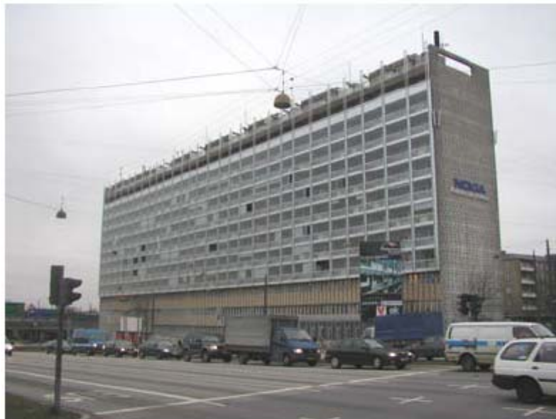
Kollektivhuset, Hans Knudsens Plads Copenhagen, Denmark. Photo: NCC.
